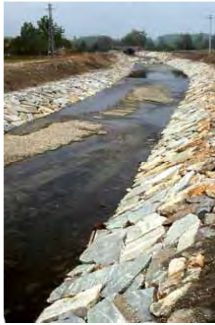
Fig. 1.12 - A sinistra un piccolo corso d'acqua biologicamente ricco e diversificato. A destra lo stesso fiume dopo un intervento di sistemazione idraulica. Un vero e proprio ecosistema fluviale è stato trasformato in una sorta di canale artificiale praticamente privo di vita ed in verità più pericoloso dal punto di vista dell'assetto idrogeologico. Infatti aumenta la velocità di corrente dell'acqua di piena (e quindi anche la sua energia erosiva) perché non più ostacolata nel suo fluire verso valle.
