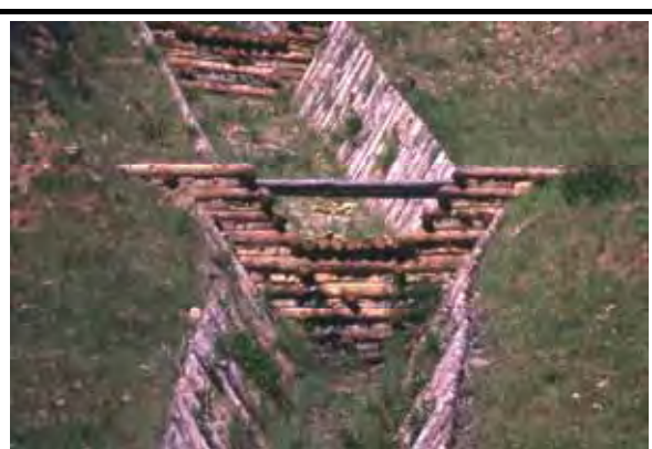
Fig. 1.63 - Esempio di briglia realizzata con le tecniche dell'ingegneria naturalistica. Si tratta evidentemente di una struttura a scarso impatto paesaggistico.
