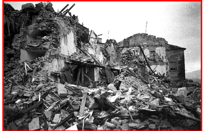
Terremoto dell'Irpinia del 1980, con magnitudo 6,9 della scala Richter registrato il 23 novembre.
